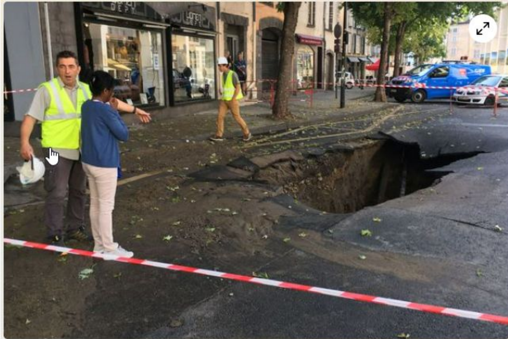
Un partie de la chaussée s'est effondrée rue Saint-Genès à Clermont-Ferrand, après la rupture d'une canalisation d'eau potable. • © S. Montero / France 3 Auvergne
